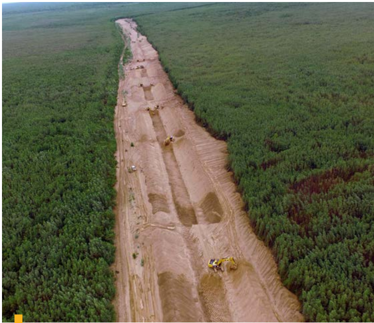
Ampliación y profundización del canal Río Pilcomayo
