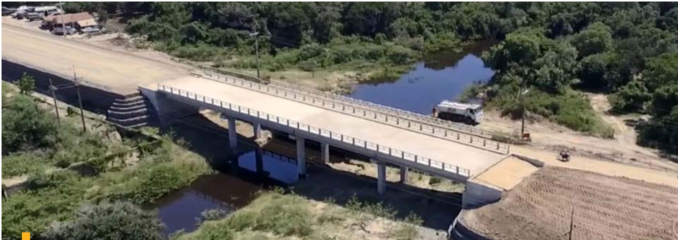
Puente sobre Arroyo Montuoso – Obra Rehabilitación del tramo desvío Alberdi - Pilar. Obra 2: Río Tebicuary - Pilar y Acceso ciudad de Pilar
