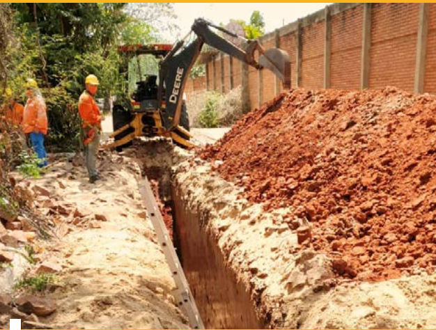
Construcción de colectores secundarios de alcantarillado sanitario para la ciudad de Fernando de la Mora
