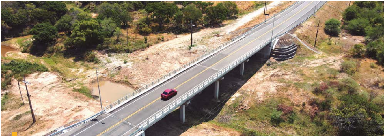
Puente Arroyo Montuoso | Obra Pilar Alberdi
