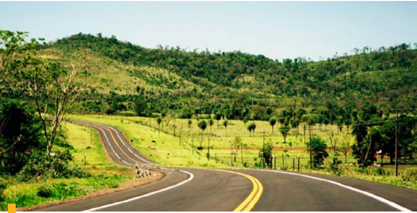
Recapado de la Ruta Nº 5 “Gral. Bernardino Caballero” Tramo: Yby yau - Km. 179
