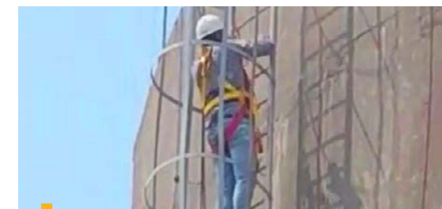
Entrenamiento de trabajos en altura
