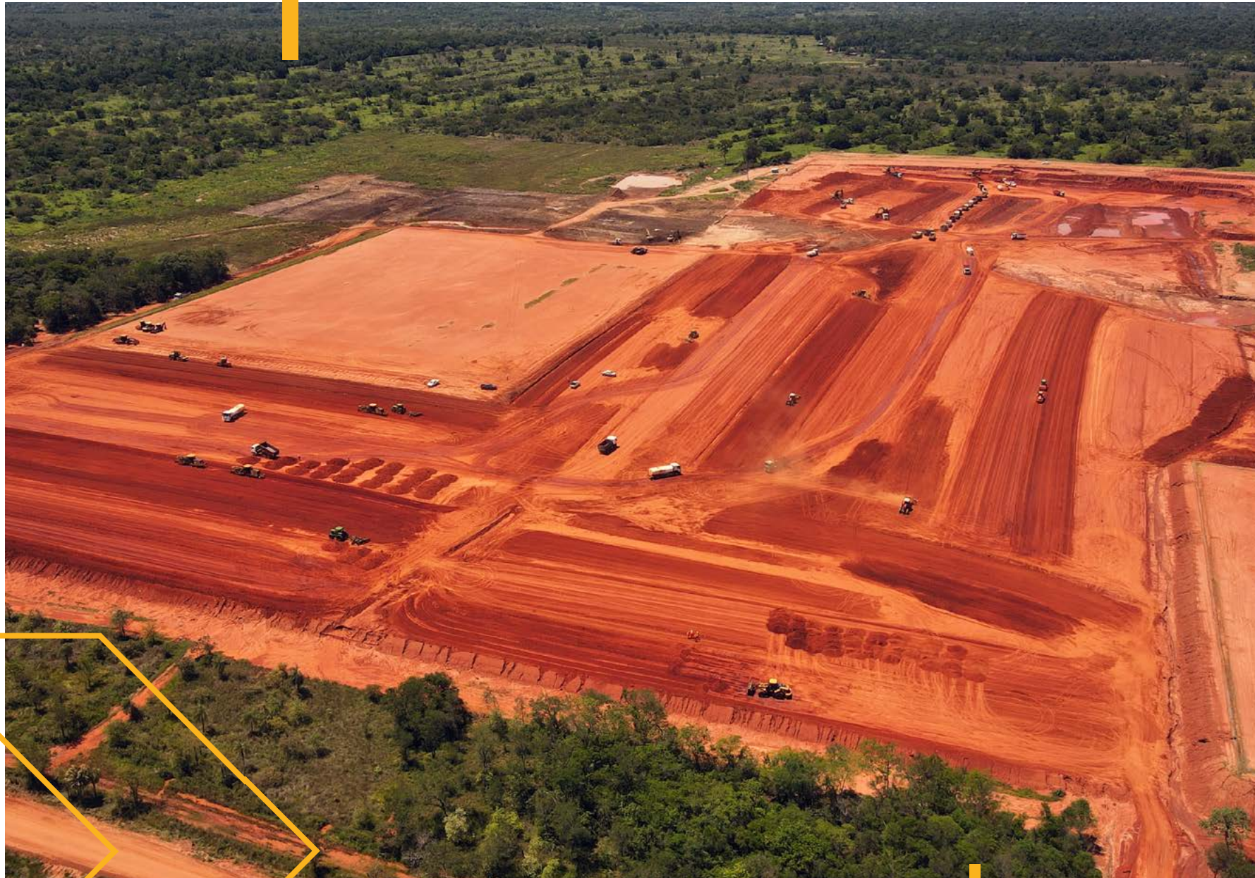
Obra Planta de Celulosa - Parcel
