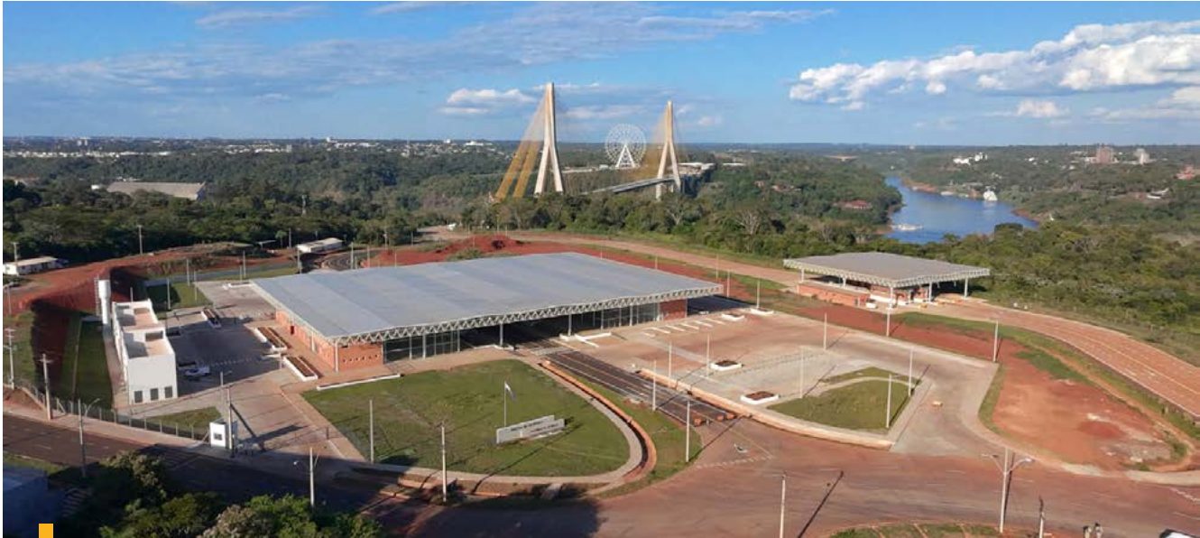
Obra Zona Primaria | Presidente Franco | Superficie cubierta 6.500 m 2
